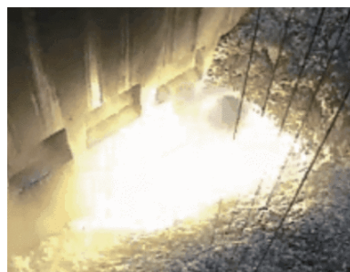
ピット火災の様子 大阪広域環境施設組合HPより転載
